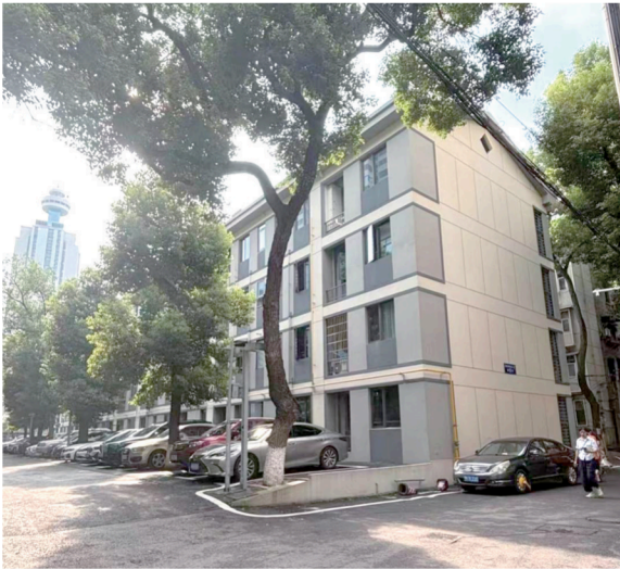
“原拆原建”后,长沙市雨花区侯家塘街道湘农桥社区面貌焕然一新。 图/中国房地产报
