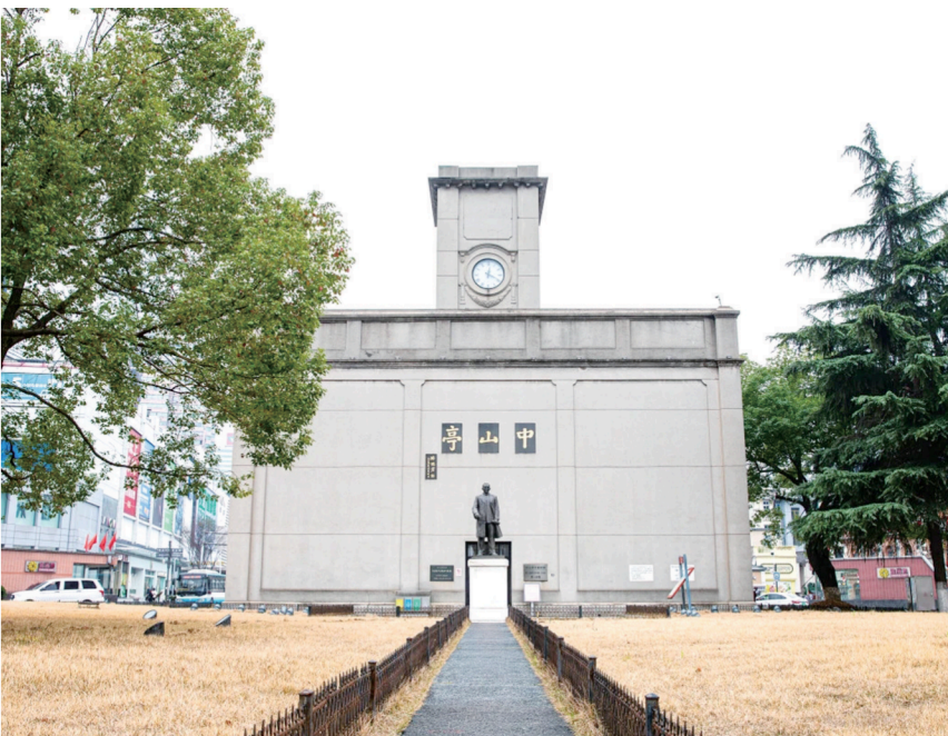
老照壁被拆除后,原址上建起了一座西式钟楼——中山亭。图/湖南政协云
