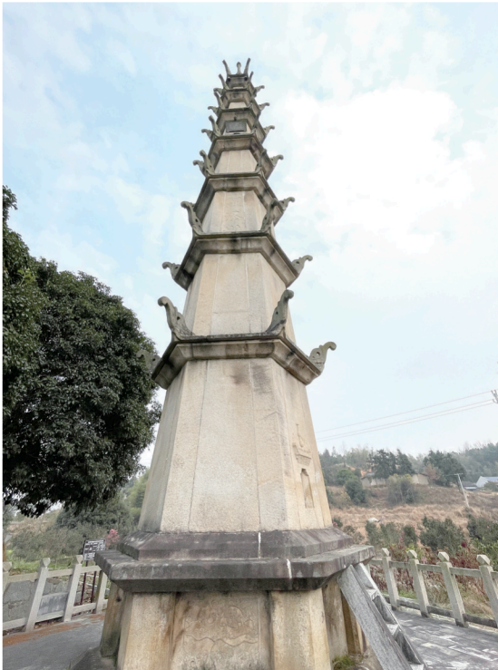
▲飘峰塔。 ▼从新湘峰寺俯瞰长沙县飘峰水库。
