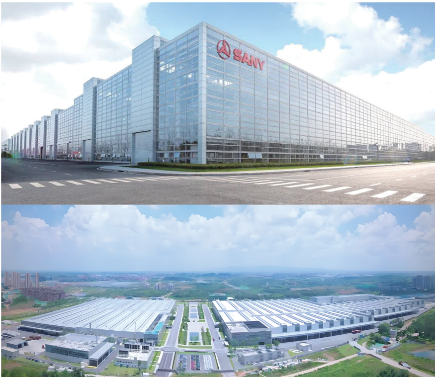
三一智联重卡产业园。组图/三一重工
