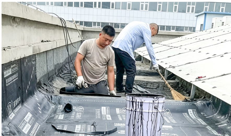
张胜在进行屋面防水施工。图/受访者提供
