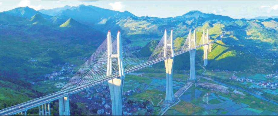
▼G76厦蓉高速公路赤石大桥。
