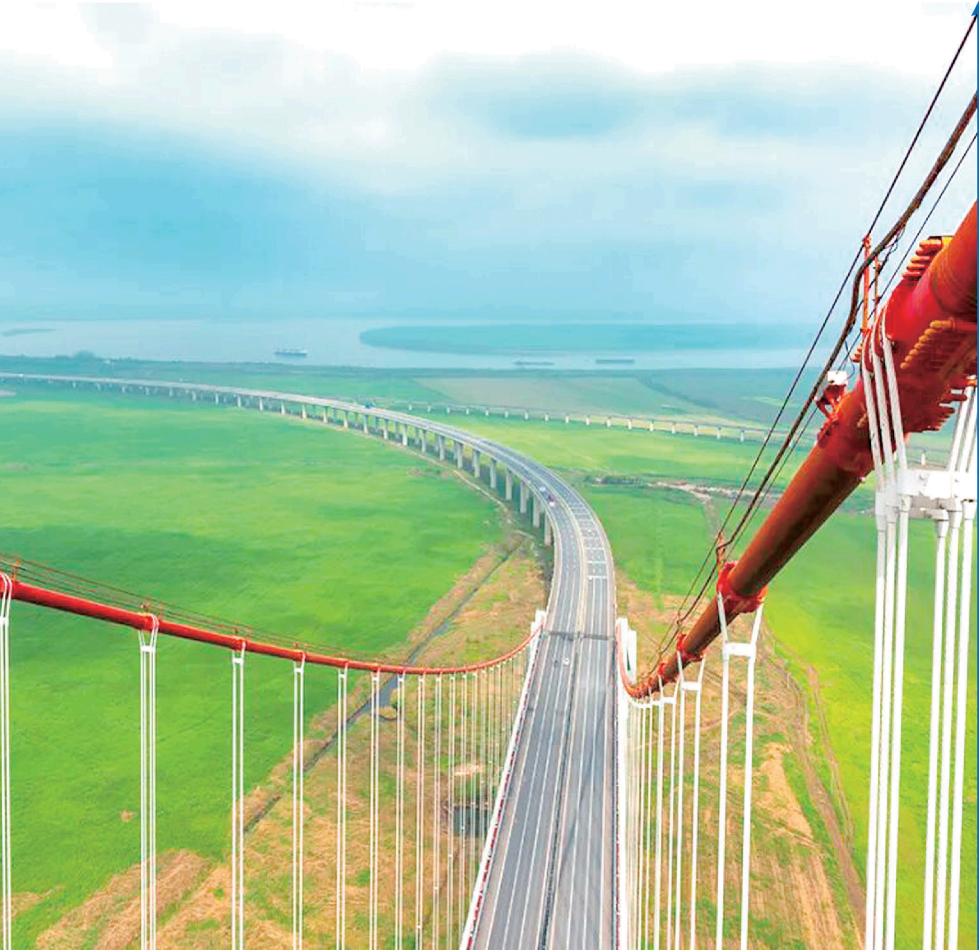
杭瑞洞庭大桥。组图/湖南高速公路
