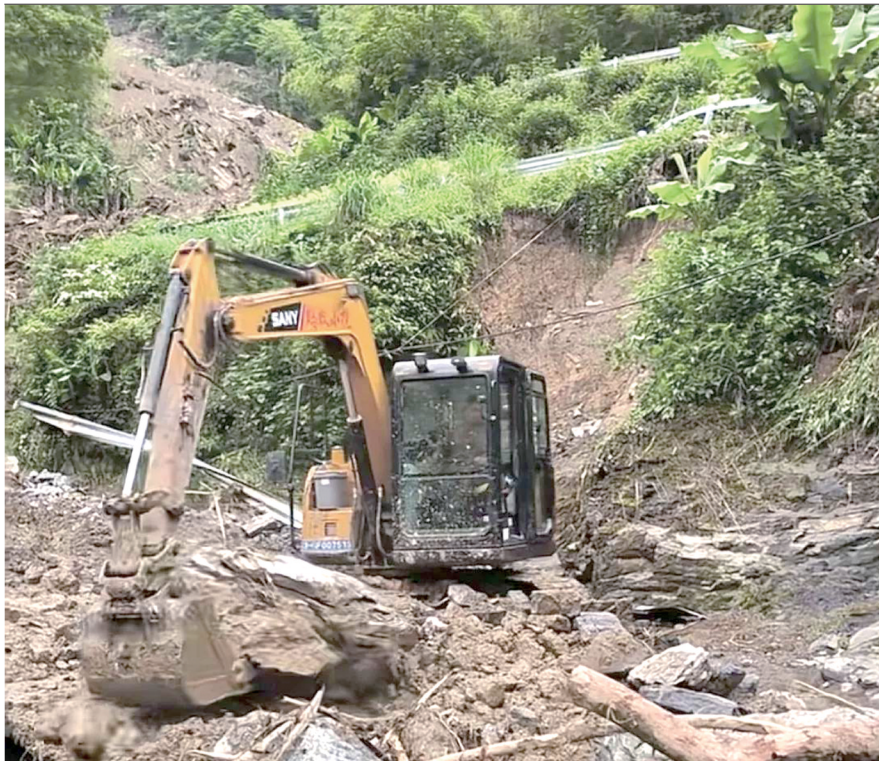
何华帅此前在常德石门驾驶挖机挖巨石。图/记者曾永红
