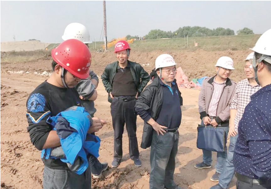
2017年10月,余元君(右四)在钱粮湖分洪闸建设工程指导施工。图/洞庭湖水利事务中心
