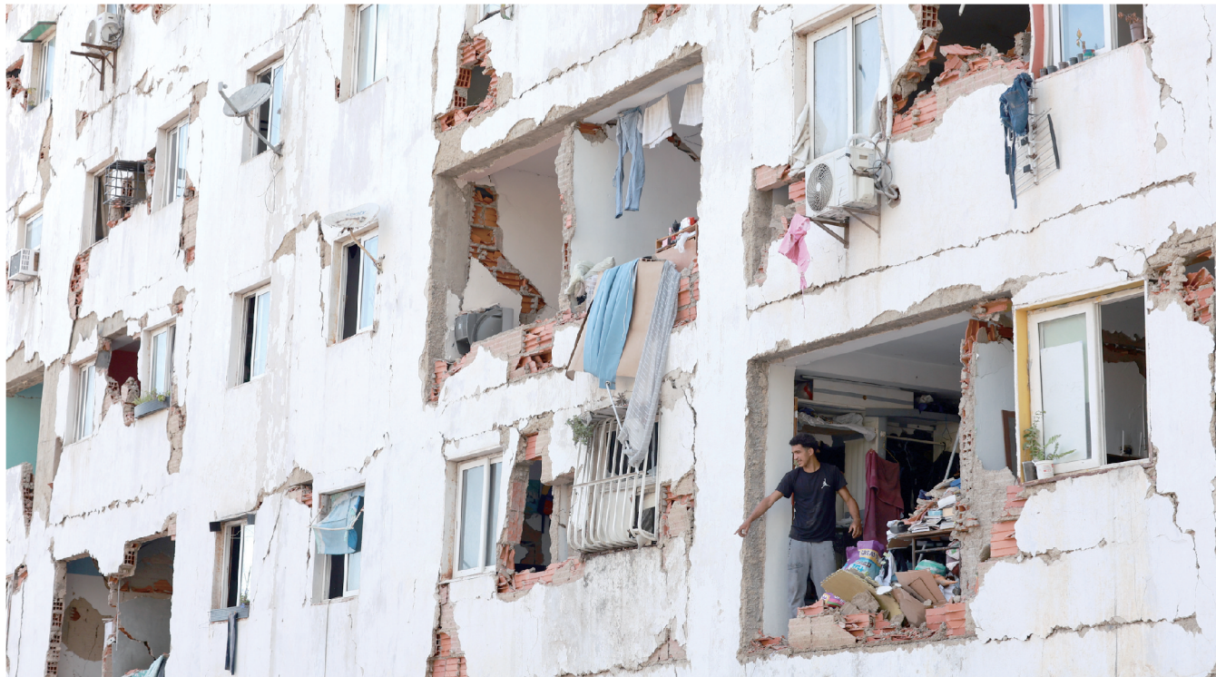
当地时间6月25日,在委内瑞拉拉瓜伊拉州,一名居民站在受损建筑中。组图/新华社
