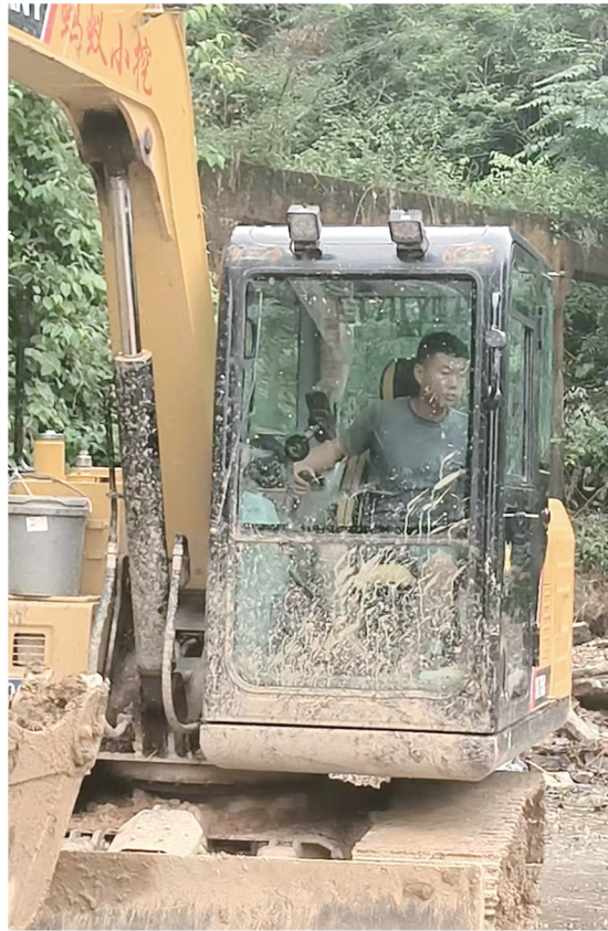
何华帅在操作挖掘机。图/记者史继超
