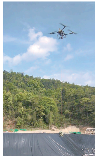
无人机吊起三袋砂石。
